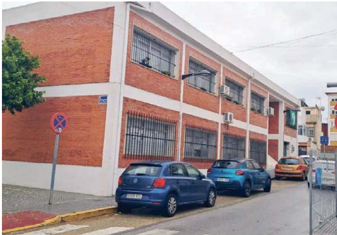
Adjudicado el contrato para la adecuación del nuevo comedor y la cocina del CEIP San Ignacio. J.F.C.
